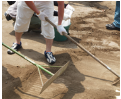
園庭の土壌の除去
