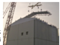
1号機原子炉建屋カバー屋根パネルの設置作業(2011年10月14日東京電力撮影)
